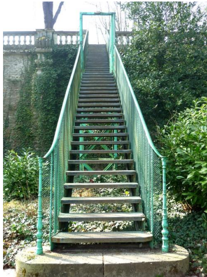
Image 12 : Passerelle métallique reliant les communs à la terrasse supérieure de l'Observatoire
