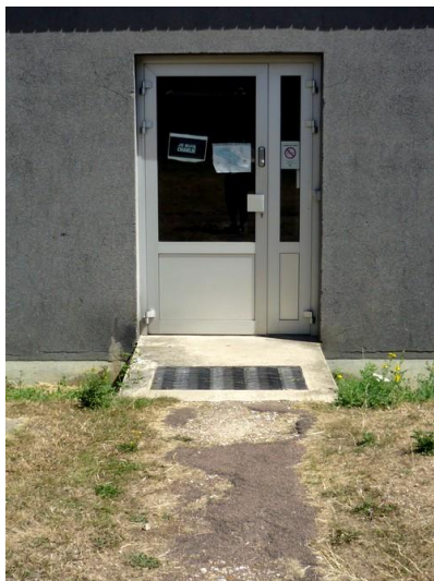
Image 14 : Entrée des bureaux situés à l'arrière de la table équatoriale
