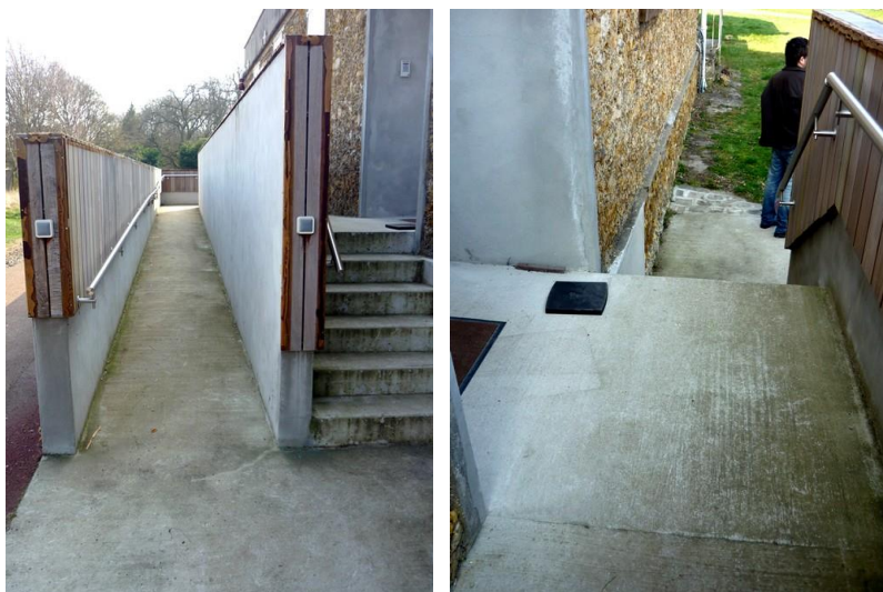
Image 15 : Rampe d'accès au grand sidérost, débouchant sur l'escalier
